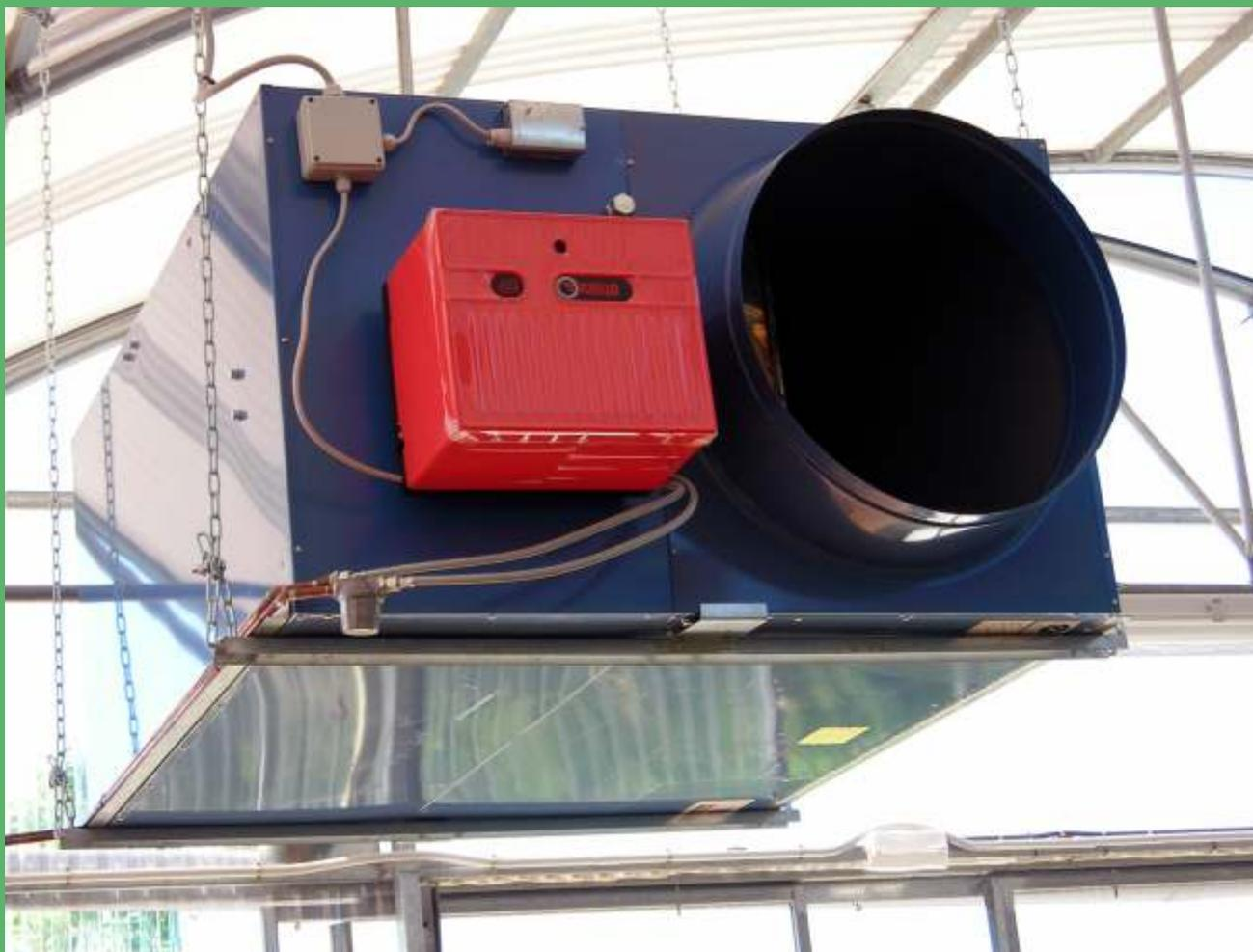
Generador de aire caliente de combustión indirecta
